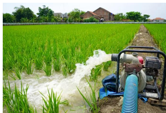
Gambar 2. Pompa Irigasi Sawah menggunakan mesin BBM
