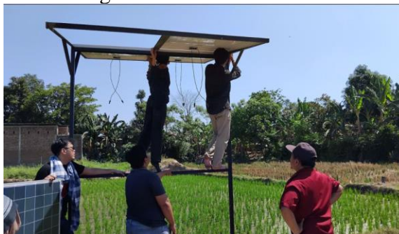
Gambar 8. Pemasangan panel surya pada sawah mitra
