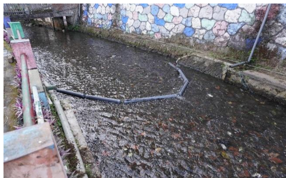
Gambar 5. Pemasangan Floating Litter Trap
