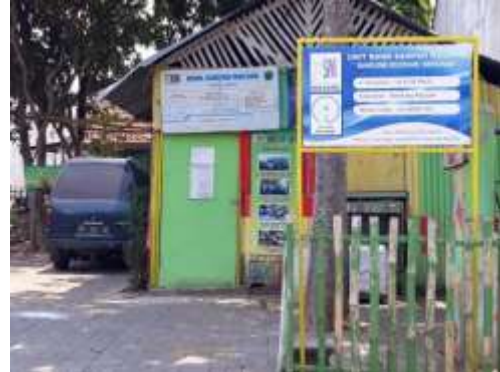
Gambar 5: Perbaikan bangunan sampah semi permanen
