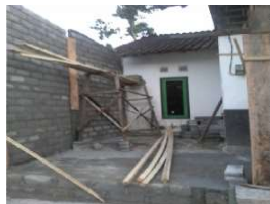
Gambar 8. Proses pembangunan outlet
