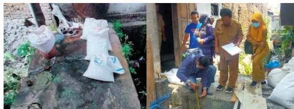
Gambar 2. Lokasi yang cukup luas sebagai destinasi konstruksi IPAL limbah tahu ( kiri ), dan saat Dinas PUPR bersama tim PKM UNISKA-Kediri melakukan investigasi lokasi destinasi ( kanan )
