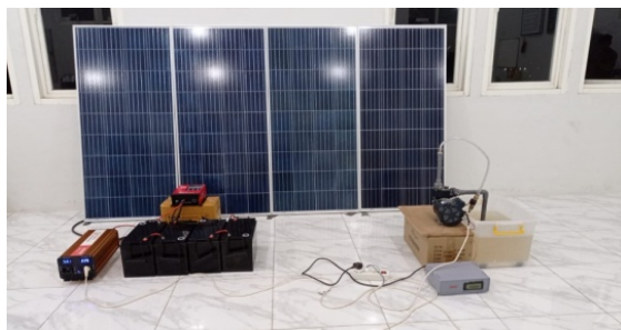
Gambar 4. Hasil Instalasi Pembuatan Pompa Air Tenaga Surya
