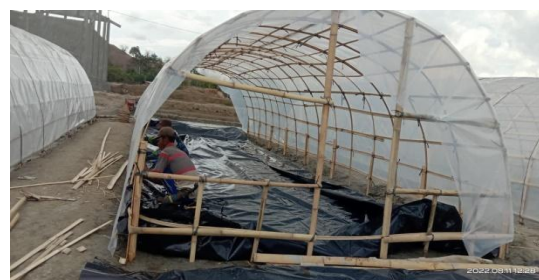
Gambar 7. Pemasangan Plastik Geomembran pada SHE
